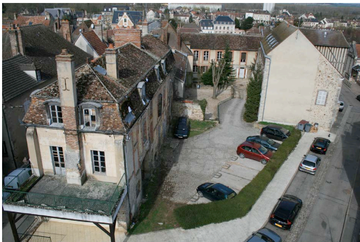
Le site de l'îlot Saint-Epoing, sur lequel sera implanté le futur musée. A gauche, la « Maison Claudel » © Ville de Nogent-sur-Seine
